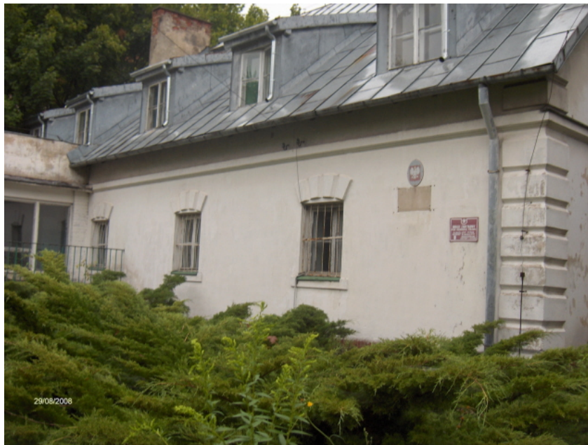
Fot. 8. Fragment elewacji zachodniej obiektu, należący do starego budynku spichrza.
