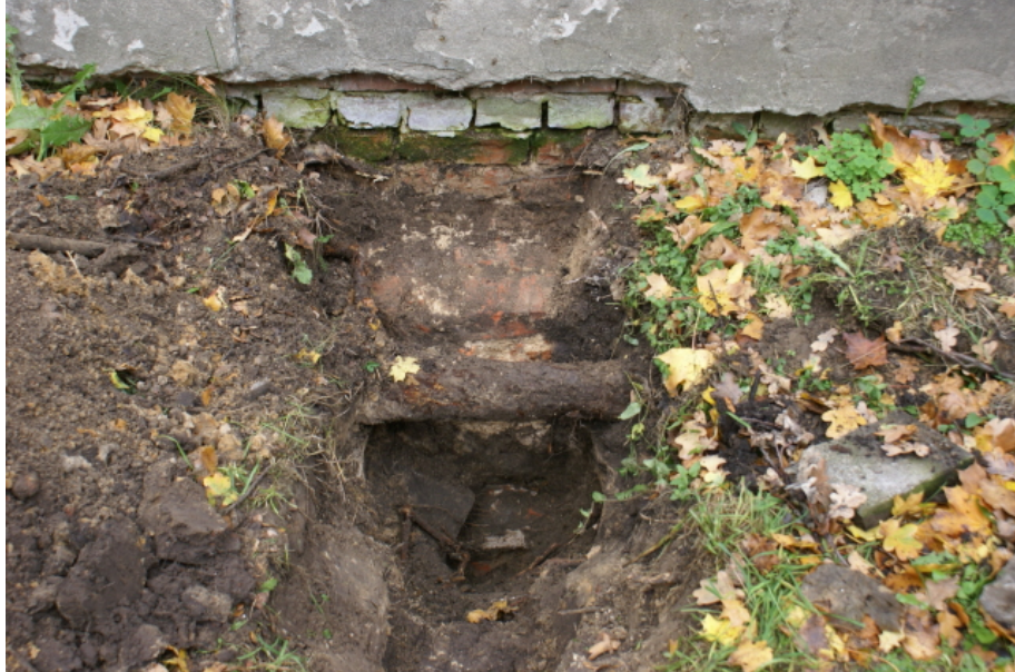
Fot. 2. Odkrywka fundamentu pałacu na elewacji wschodniej
