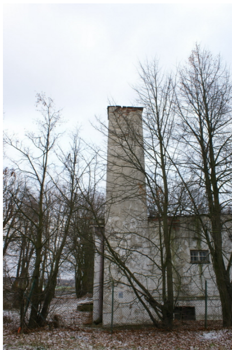
Fot. 9. Elewacja zachodnia przybudówki. Widoczny przylegający do budynku, murowany komin
