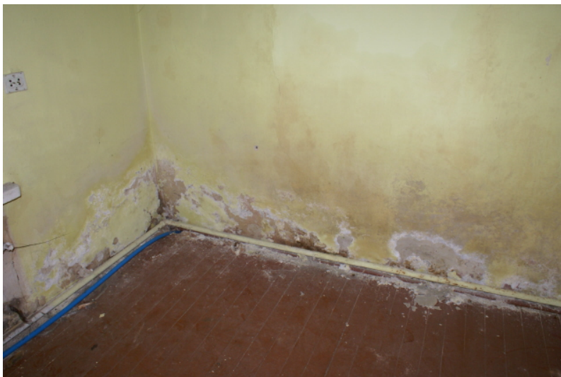
Fot. 7. Widok narożnika północno- wschodniego od wewnątrz budynku
