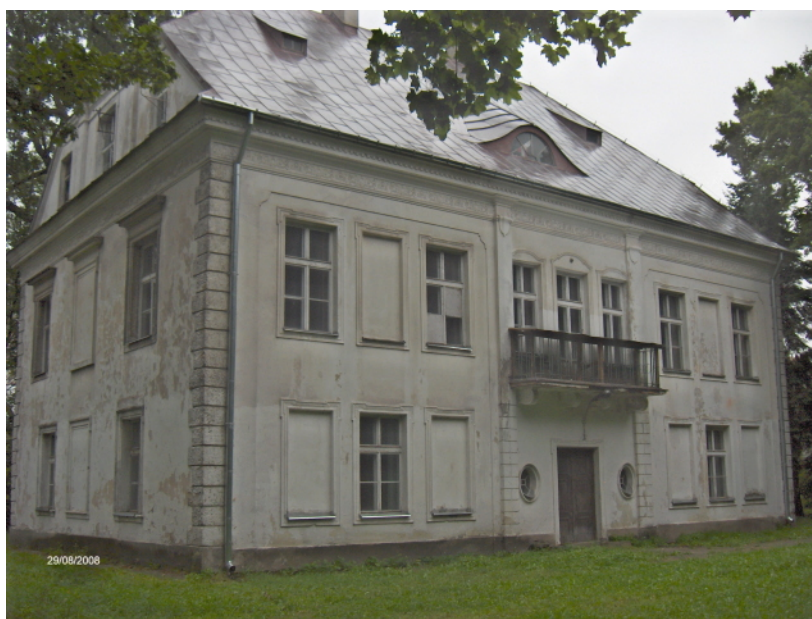
Fot. 1. Elewacja główna (wschodnia) i południowa pałacu
