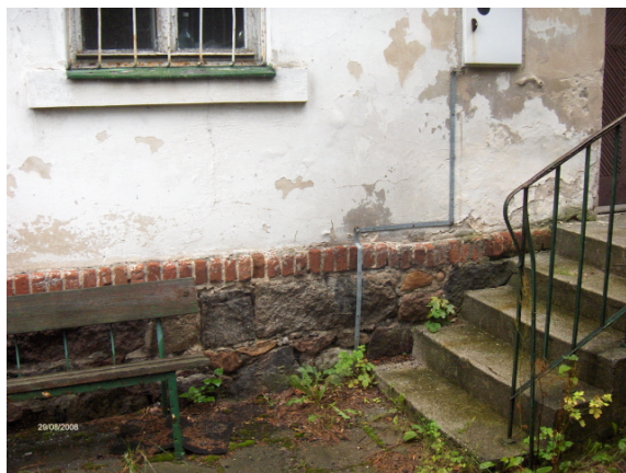
Fot. 5. Uszkodzenia tynku przy wejściu głównym do budynku spichrza, spowodowane zawilgoceniem od wód rozbryzgowych
