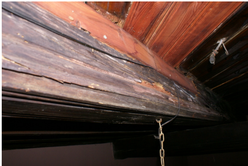
Fot. 20. Uszkodzenia drewna spowodowane korozją widoczne są również na powierzchni belek
