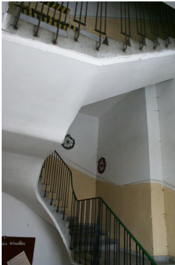
Fot. 15. Klatka schodowa w pałacu pomiędzy pierwszym piętrem a poddaszem
