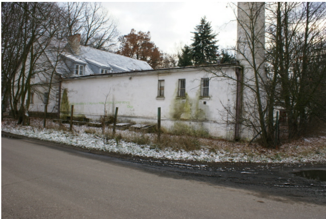
Fot. 11. Elewacja północna spichrza i przybudówki
