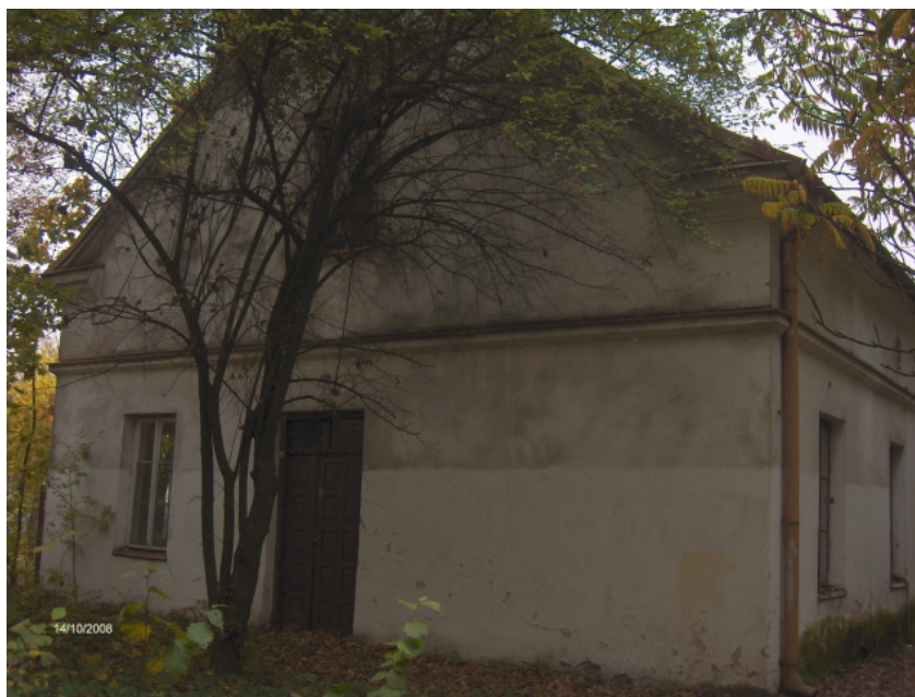
Fot. 5. Uszkodzenia tynku spowodowane zawilgoczeniami i zasoleniami na elewacji południowej
