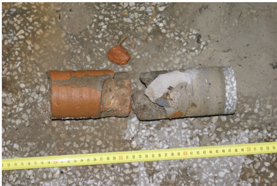
Fot. 13. Rdzeń wycięty z płaskiego fragmentu stropu nad parterem
