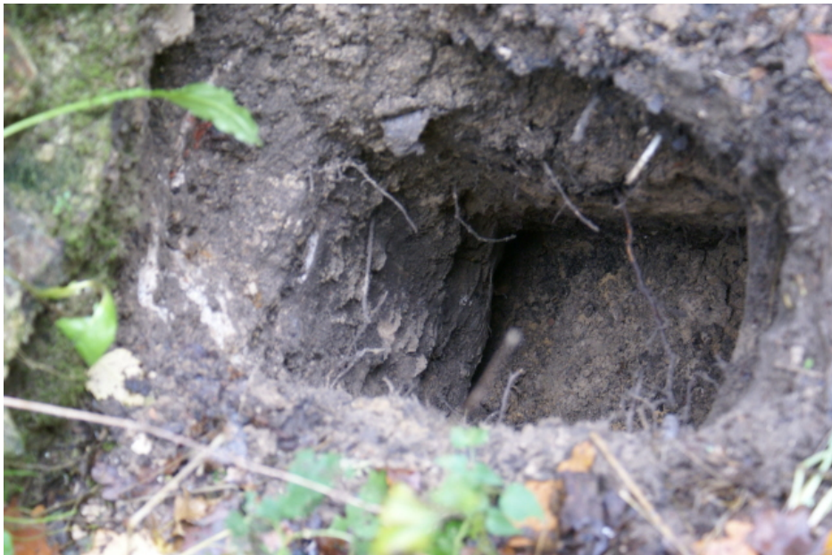
Fot. 3. Odkrywka fundamentu na elewacji północnej
