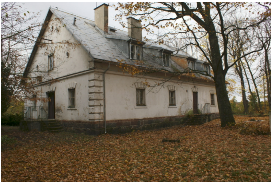
Fot. 3. Elewacja wschodnia spichrza i część elewacji południowej z wejściem na szczycie starej części budynku
