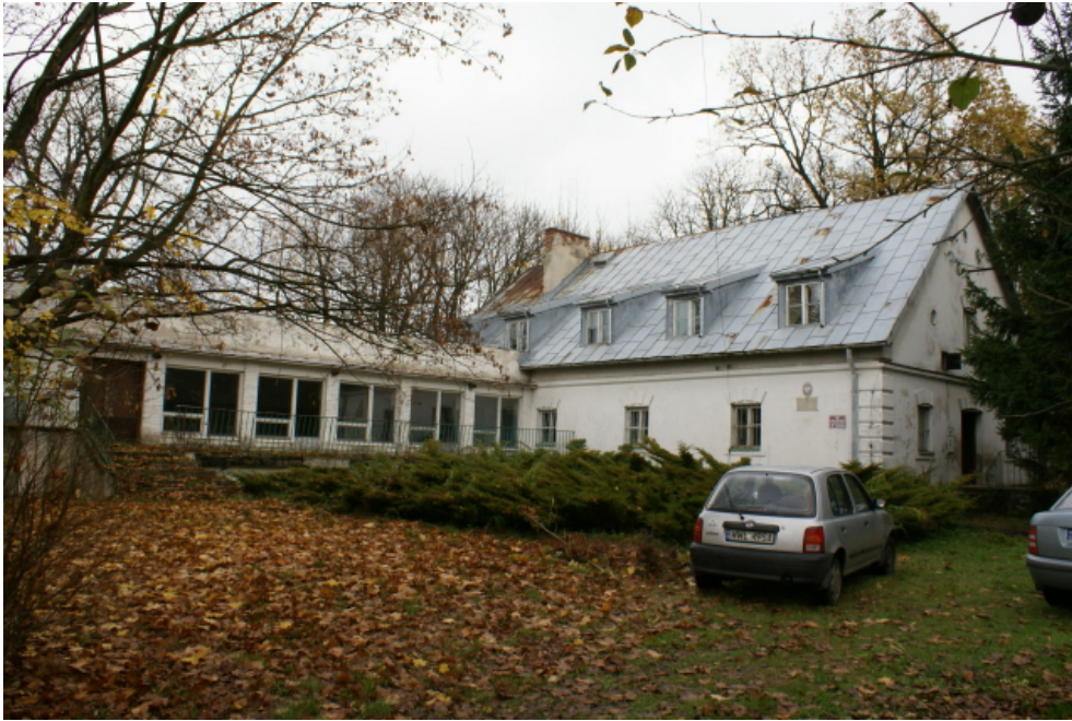
Fot. 1. Widok ogólny spichrza wraz z przybudówką z lat 60-tych ubiegłego wieku
