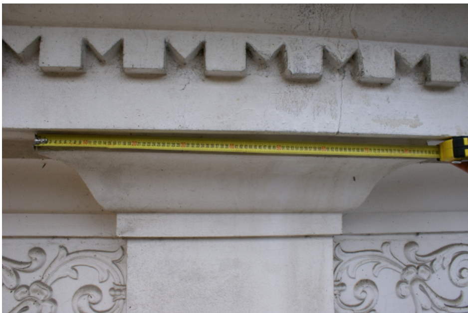
Fot. 9. Gzyms nad pierwszym piętrzem z wzorem geometrycznym
