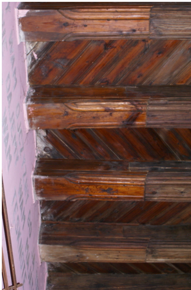
Fot. 16. Przykład naprawy belek stropowych, polegającej na wymianie ich końcówek przy gniazdach w ścianie nośnej
