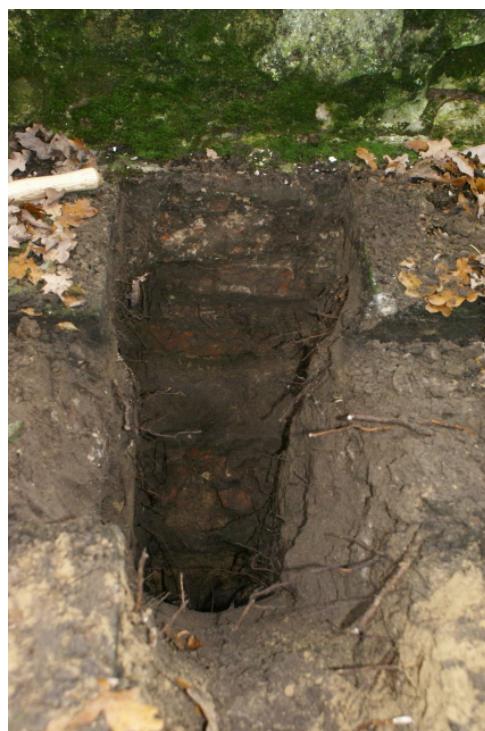
Fot. 2. Odkrywka fundamentu na elewacji wschodniej
