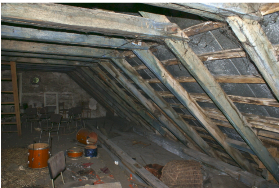
Fot. 22. Więźba dachowa na strychu spichrza
