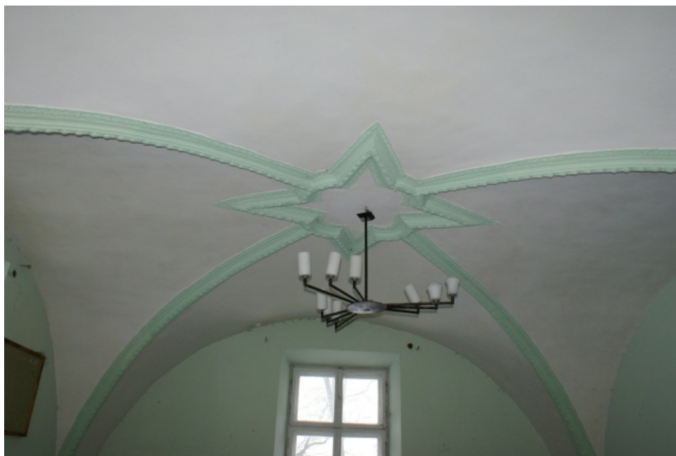
Fot. 14. Sklepienie krzyżowe nad parterem w pomieszczeniu w narożu południowo-wschodnim
