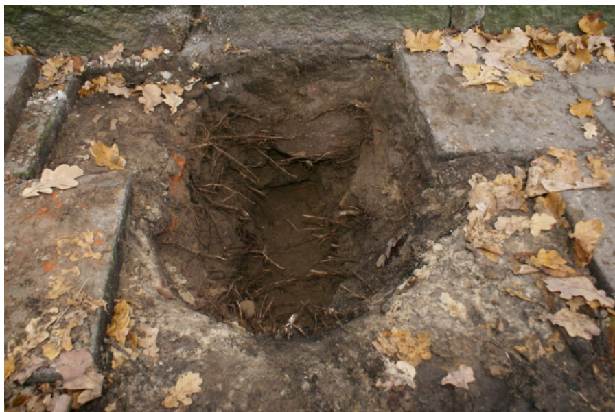
Fot. 2 Wykonana odkrywka fundamentu budynku
