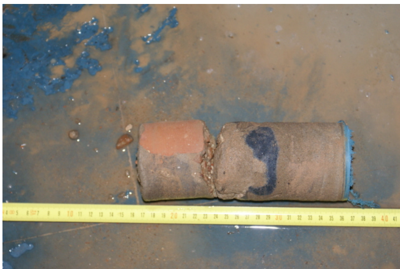
Fot. 15. Rdzeń wycięty z posadzki parteru
