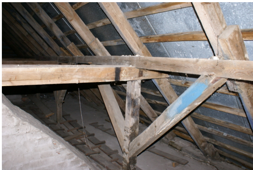
Fot. 25. Fragment więźby płatwiowo kleszczowej dachu pałacu
