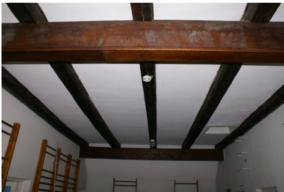
Fot. 23. Strop nad pierwszym poziomem poddasza w obszarze dawnej sali gimnastycznej.
