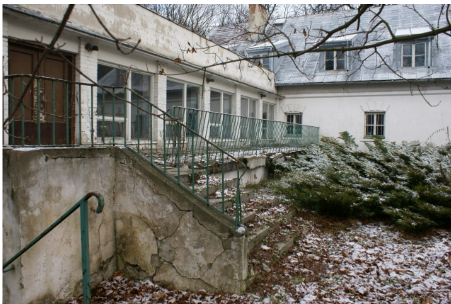
Fot. 6. Część elewacji południowej należąca do dobudowanej stołówki
