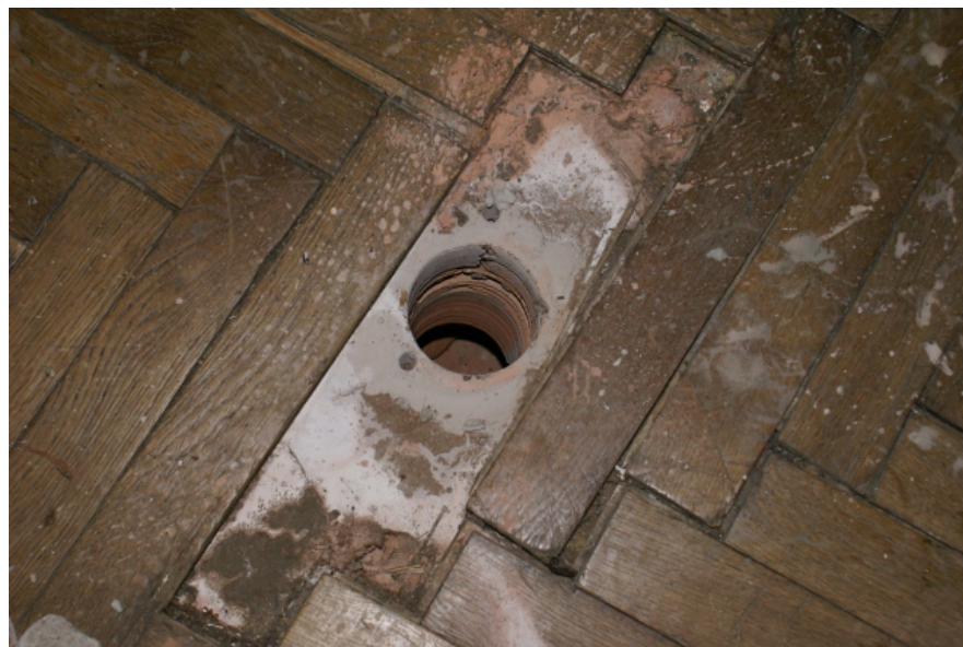
Fot. 22. Miejsce wycięcia rdzenia. Poniżej płyty Kleina w konstrukcji stropu występuje pustka
