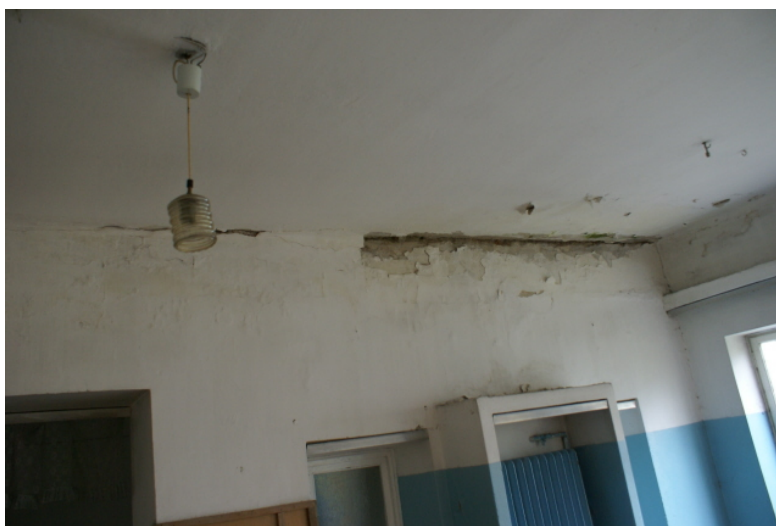
Fot. 18. Stan dylatacji pomiędzy spichrzem a dobudowaną stołówką – widok od strony stołówki
